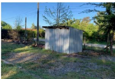
Casetas, Pozos y Bombas
