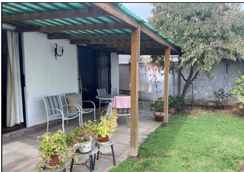
Fotografía 5: Terraza Techada (A2)
