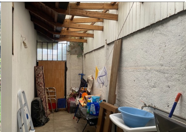
Fotografía 6: Patio de Servicio techado (A1)
